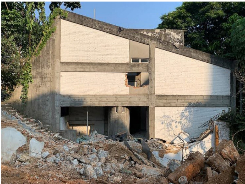
Figura 2 – Vista do ateliê após a demolição do muro lateral. Foto: Felipe Contier, 2020
