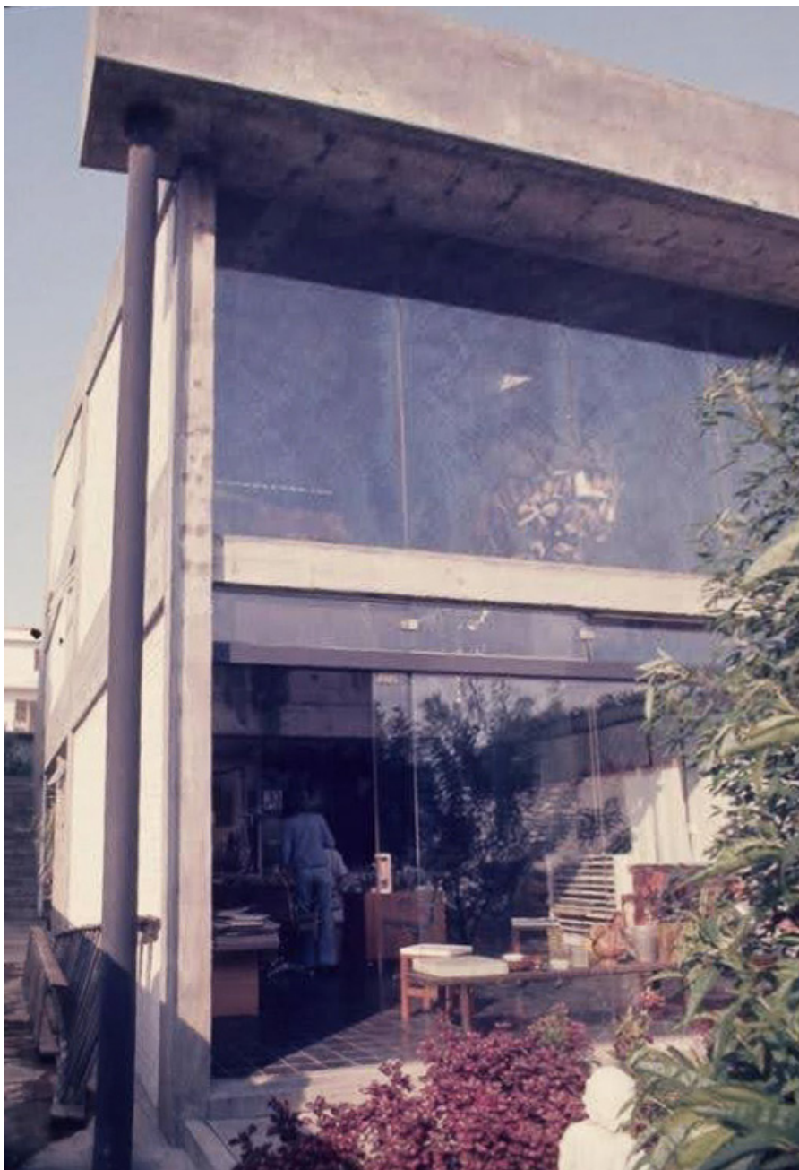
Figura 9 – Vista a partir do quintal do fundo, com recuo lateral e viga-calha com tubulação pluvial. Foto: Marcio Mazza, 1989. Acervo da Biblioteca da FAU/USP (ARQUIGRAFIA, s. d.)
