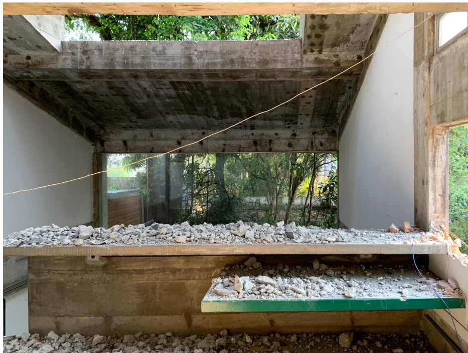
Figura 3 – Interior do ateliê em demolição. Foto: Felipe Contier, 2020
