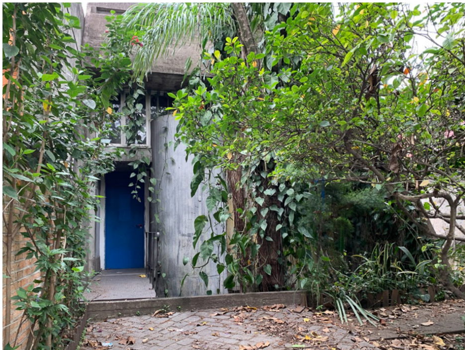
Figura 1 – Vista do ateliê a partir do tapume para demolição instalado na rua Paracuê. Foto: Felipe Contier, 2020
