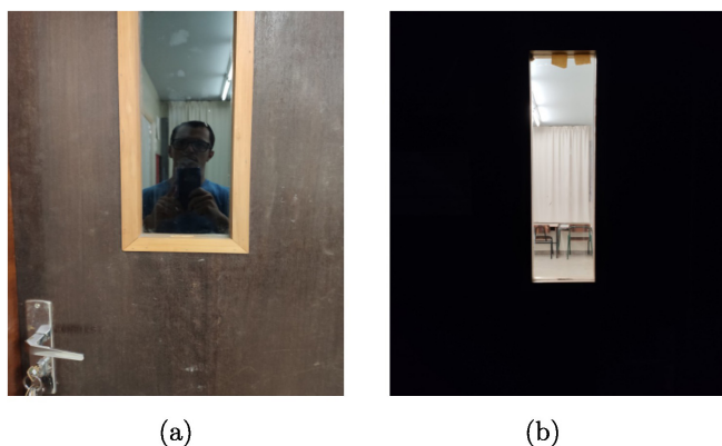
Figura 16: (a) Em um ambiente interno iluminado, o vidro se comporta como um espelho. (b) Em um ambiente externo escuro, o vidro se comporta como um meio transparente.
