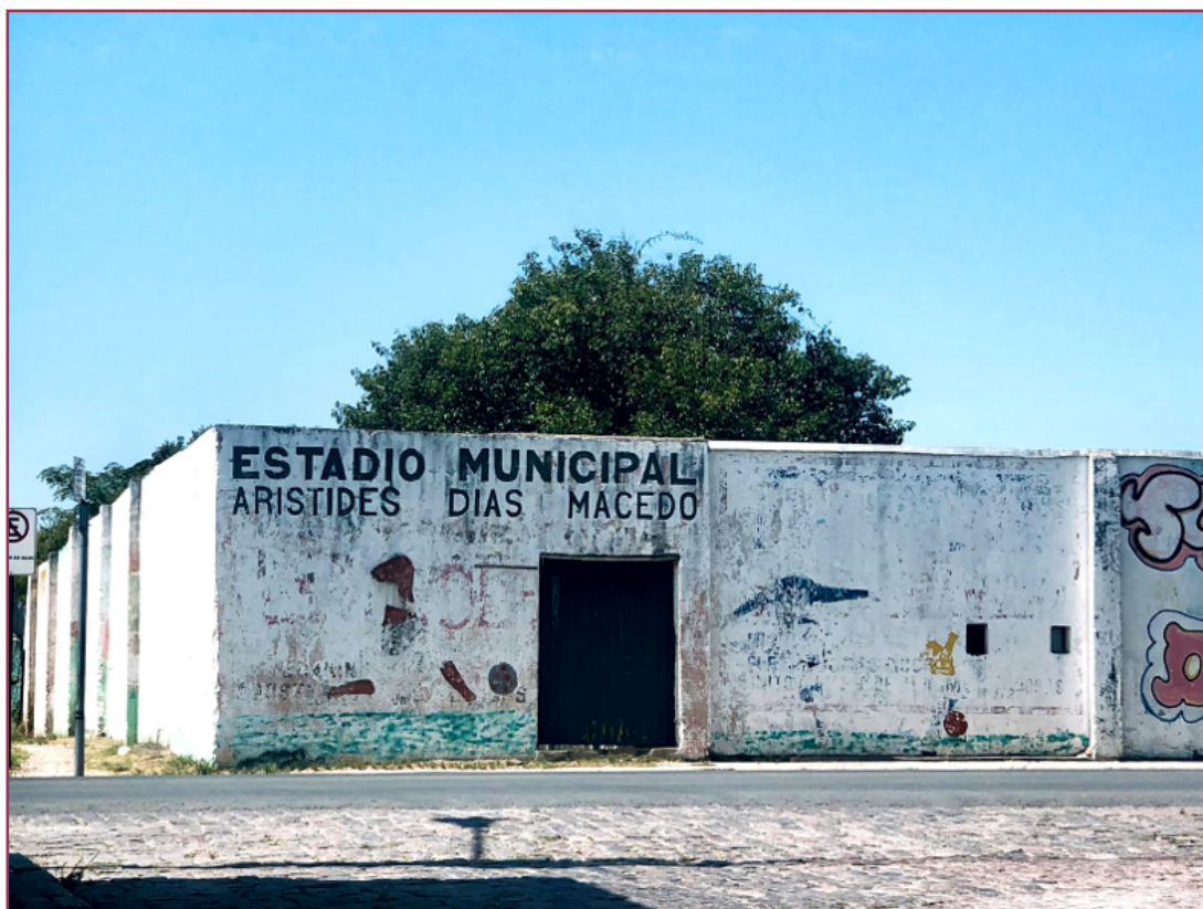
Figura 2 - Portão da entrada leste do estádio
