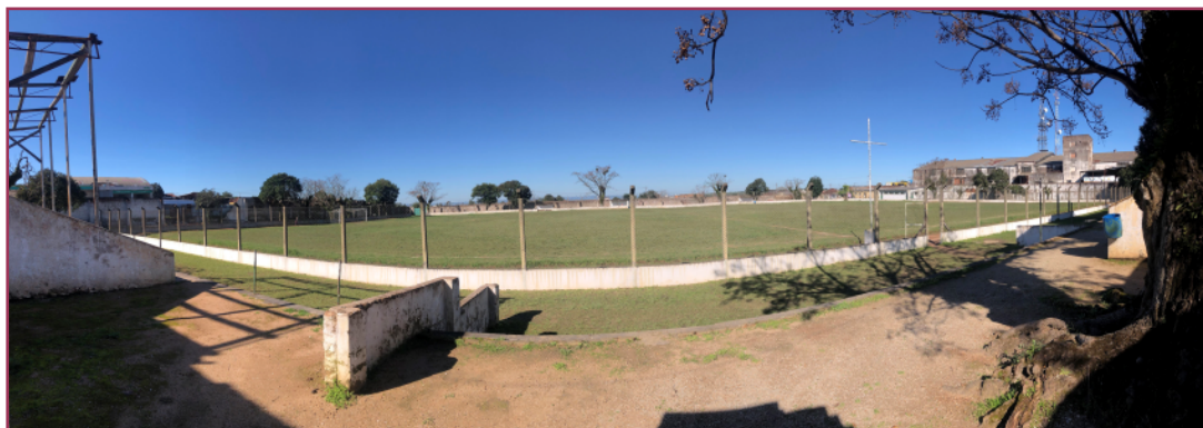
Figura 4 - Vista panorâmica do campo da entrada central do estádio
