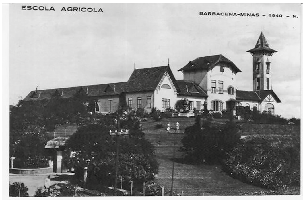
Figura 3 – Vista do prédio central do Aprendizado Agrícola de Barbacena (Escola Agrícola de Barbacena)
